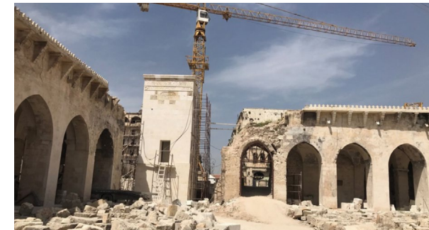
الصورة ٣: إعادة بناء مئذنة الجامع الأموي الكبير في حلب التاريخية.
